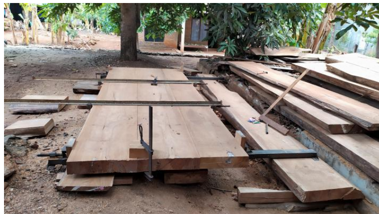
Gambar 36. Proses penyambungan bahan kayu. (foto dokumentasi Tomihendra Saputra).
