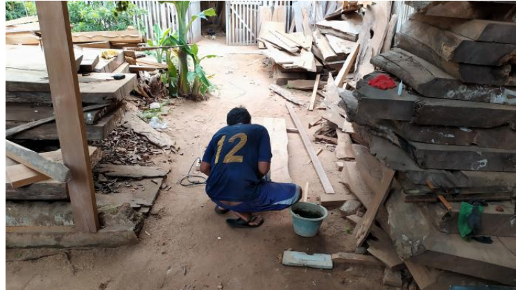
Gambar 35. Proses pemotongan bahan kayu. (foto dokumentasi Tomihendra Saputra).
