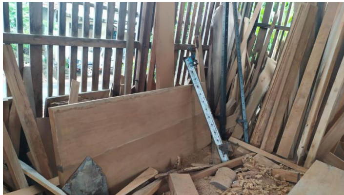
Gambar 19. Kondisi bagian dalam ruangan penyambungan kayu.
