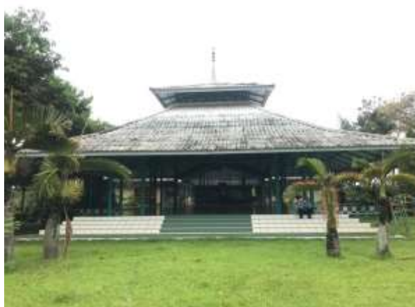
Gambar 4.1 Gedung SLB PRI Kota Pekalongan (Dokumen Peneliti, 2020)
