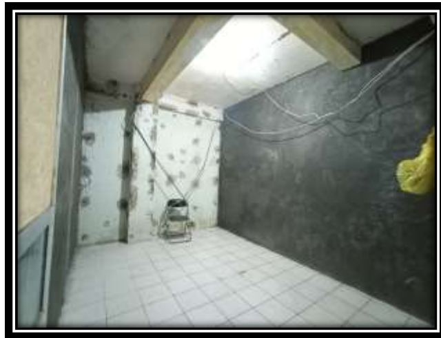
Gambar 4.22 Ruang studio yang sedang direnovasi. (Dokumentasi INDRI, 10 Maret 2020)
