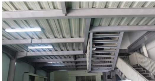
Gambar 2.105 Struktur Baja pada Ruang Kantor JCC Sumber : Dokumentasi Pribadi
