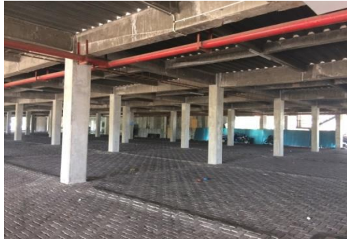
Gambar 2.71 Area Parkir Basement Marina Convention Center Semarang Sumber : Dokumentasi Pribadi
