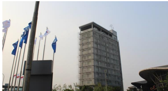
Gambar 2.113 Hotel ICE Sumber : Dokumentasi Pribadi
