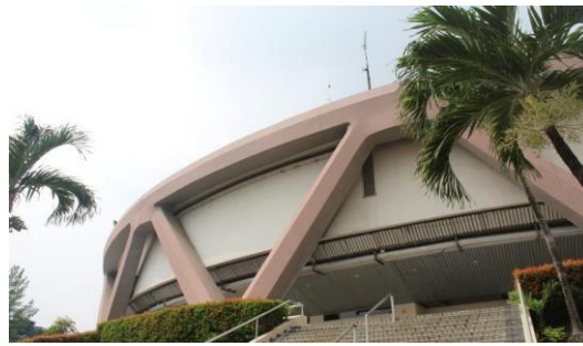
Gambar 2.104 Struktur Kolom dan Balok JCC Sumber : Dokumentasi Pribadi
