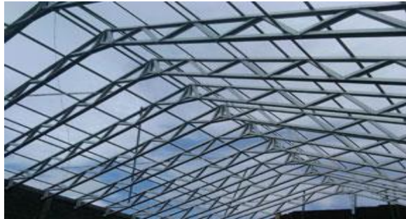
Gambar 2.26 Struktur Truss Sumber : http://techno.diwarta.com
