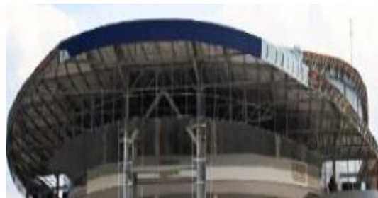
Gambar 2.76 Struktur Atap Marina Convention Center Sumber : Dokumentasi Pribadi
