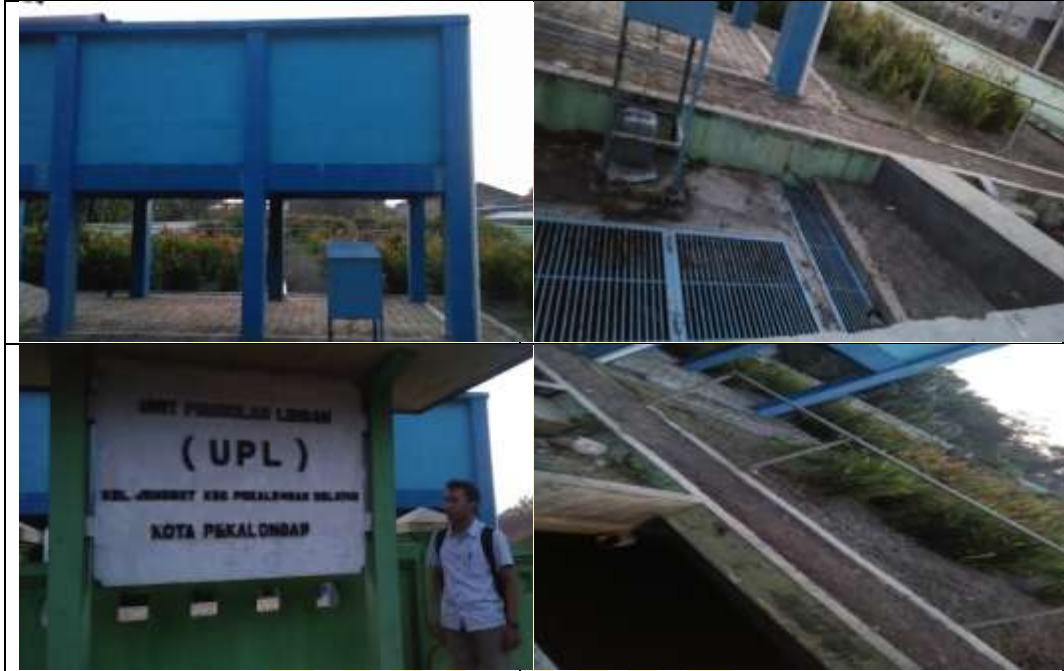
Gambar 1.5. Kondisi Instalasi Pengolahan Air Limbah (IPAL) Kelurahan Jenggot Kecamatan Pekalongan Selatan Kota Pekalongan
