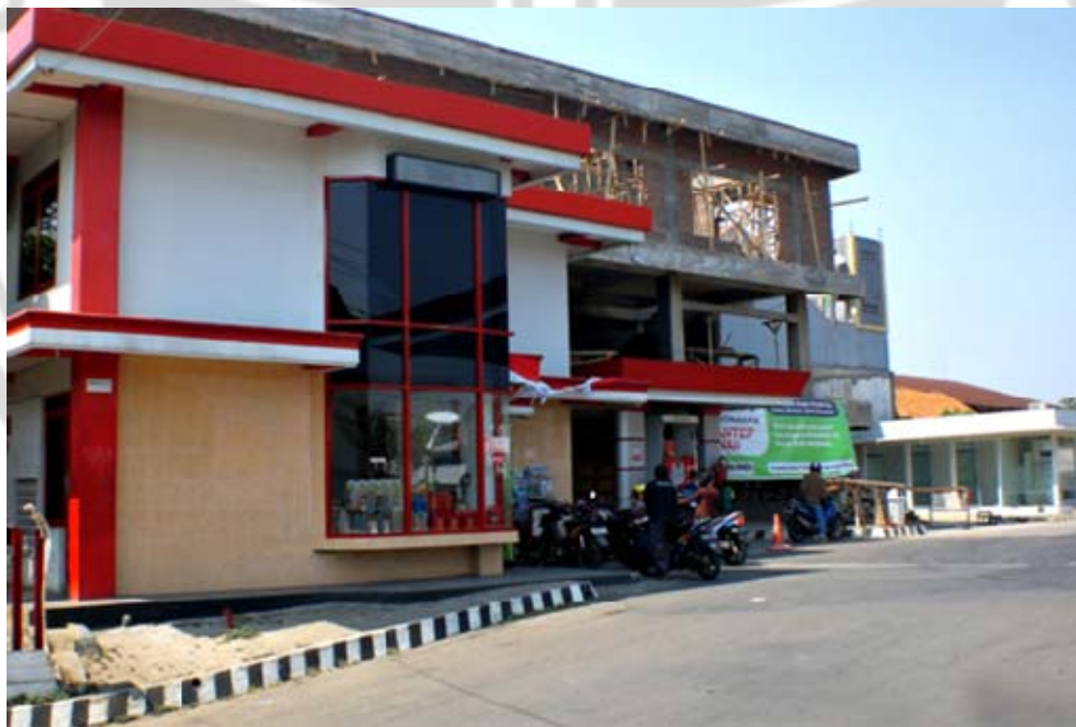
Fasilitas mini market, mushola, toilet, dan tempat pencucian mobil (dalam proses pembangunan)
