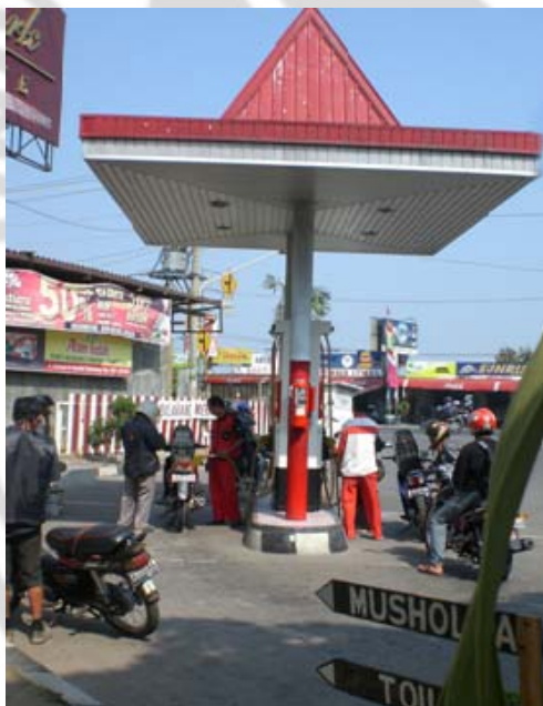
Bangunan SPBU lama
