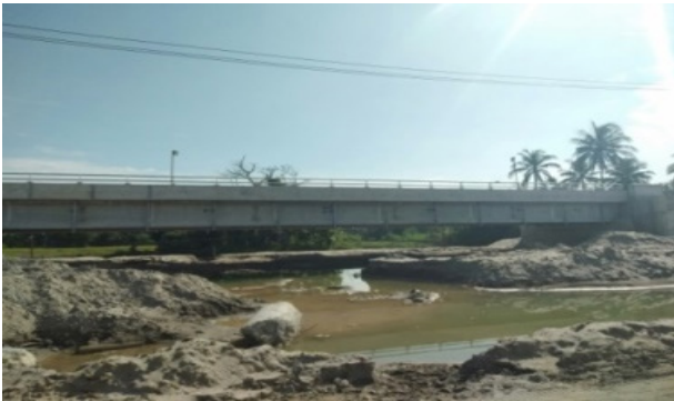
Gambar 21. Pembangunan kembali jembatan Sumber: Foto Meri, April, 2019
