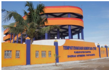
Gambar 29. Pembangunan tempat evakuasi Sumber: krjogja.com . 2017
