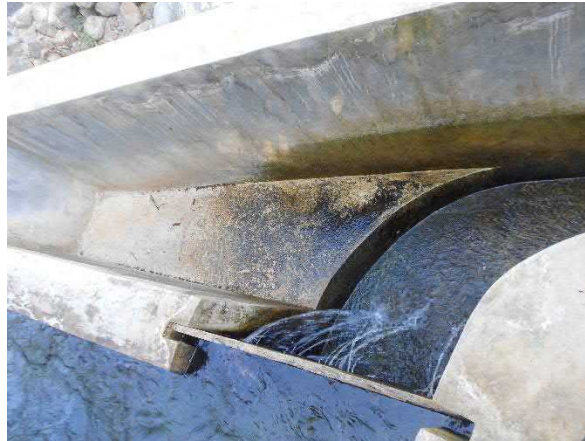
Gambar 2.4 Saluran Pelimpah (Sumber: Dokumentasi PLTMH Sokokembang)
