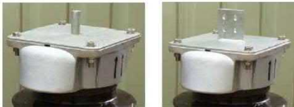
Gambar 2.7 Terminal pejal (kiri) dan Terminal plat (kanan) Sumber : (Rizaldy, 2017)
