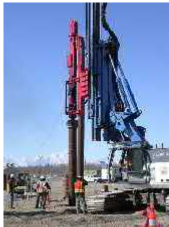
Gambar 5.29. Pondasi Tiang Pancang
