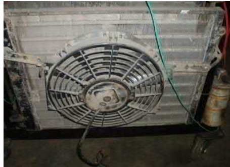
Gambar 2.2 Kondensor(Depdiknas. 2005)
