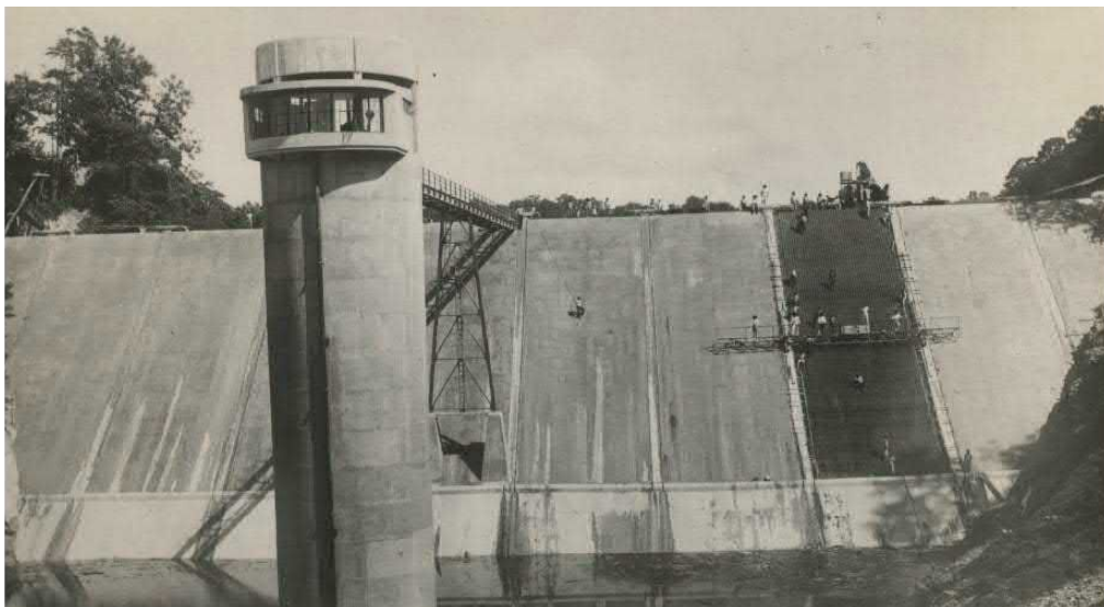
Gambar 6: Pembangunan Waduk Pacal
