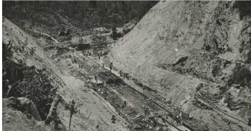
Gambar 3: Pembangunan Waduk Pacal
