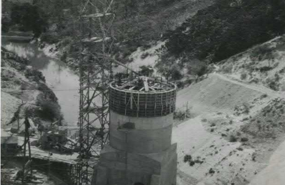
Gambar 5: Pembangunan Waduk Pacal
