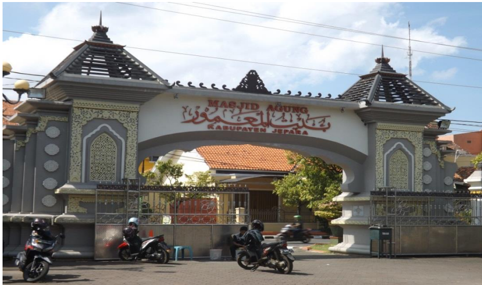
Gambar 6.3. Gapuro masuk Masjid Agung Baitul Makmur Jepara Sumber. Dokumentasi peneliti
