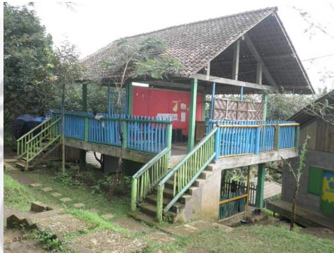
Gambar 1. Ruang untuk belajar-mengajar di SD Alam Ungaran (Sumber: Dokumen Noorman, 22 Februari 2011)
