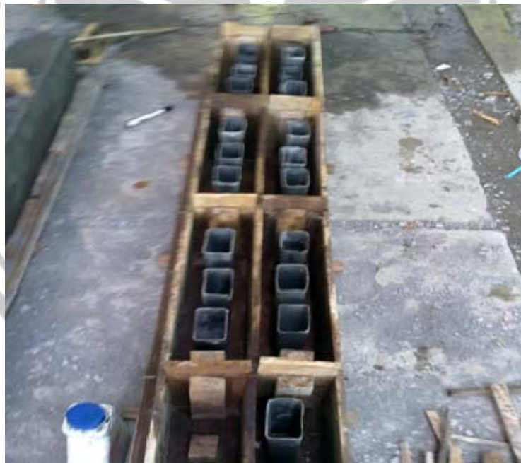
Cetakan menggunakan kayu dan potongan pralon sebagai lubang
