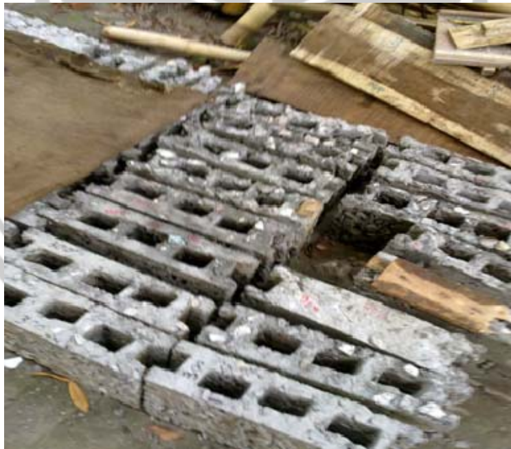
Proses perawatan bata beton dengan cara ditutup kain goni dan disiram air
