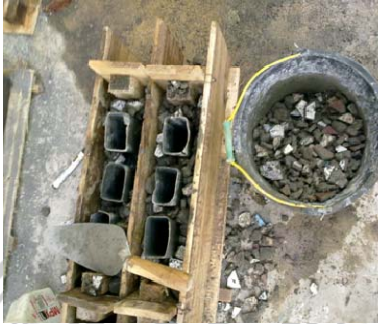
Proses pemasukan adukan bata beton kedalam cetakan
