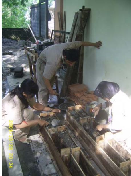
Proses Pengecoran dan Pemasakan
