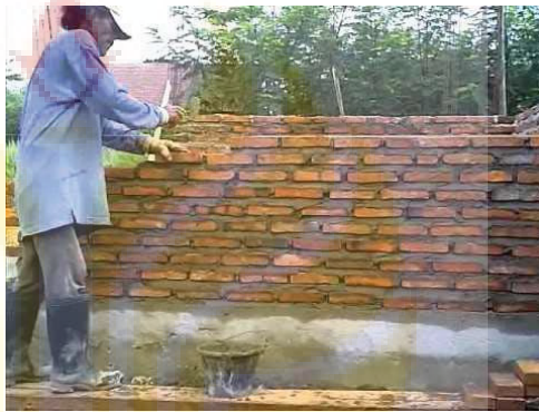
Gambar 5.3 Dinding batu bata Sumber: mobile.solusiproperti.com
