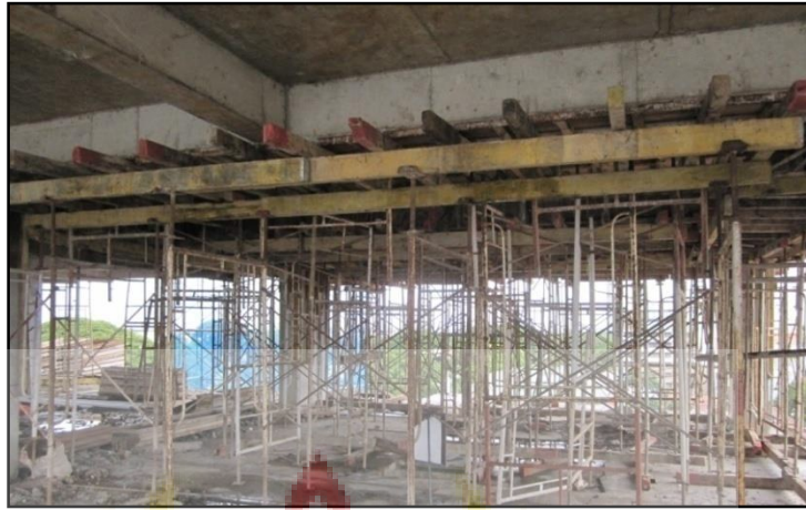
Gambar 2.10 Perancah atau scaffolding
