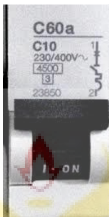
Gambar 2.7 Simbol MCB dan Toggle Switch
