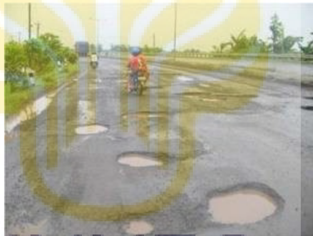
Gambar 2.2. Lubang pada badan jalan (Bakti, 2005)
