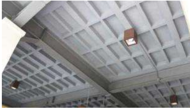
Gambar 5.23 plat beton, dan balok
