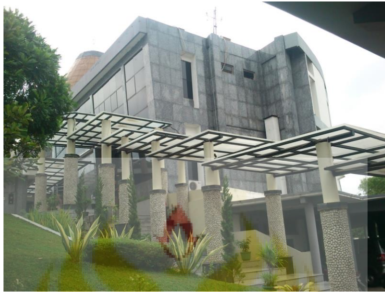
Gambar. 2.38 Tampak Bangunan Pengelola Museum Sumber : Foto Pribadi
