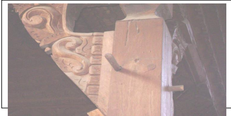
Gambar 9.7. Penggunaan pasak bambu untuk penyambungan antar tiang/sambungan kayu.
