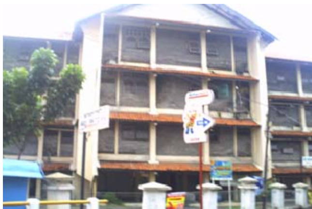
Gambar 1. Kondisi bangunan Rusunawa Pekunden kota Semarang (dokumen foto pribadi, 21-11-2010).
