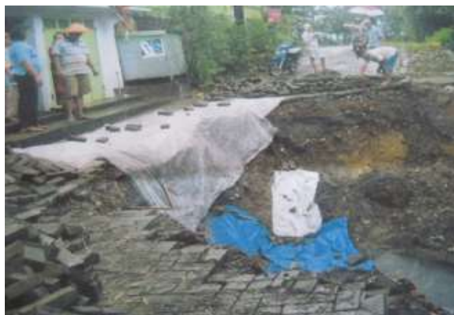
Gambar 4.9 Talud Longsor di Jl. Gotong Royong Rt 06 Rw V, Kelurahan Tinjomoyo
