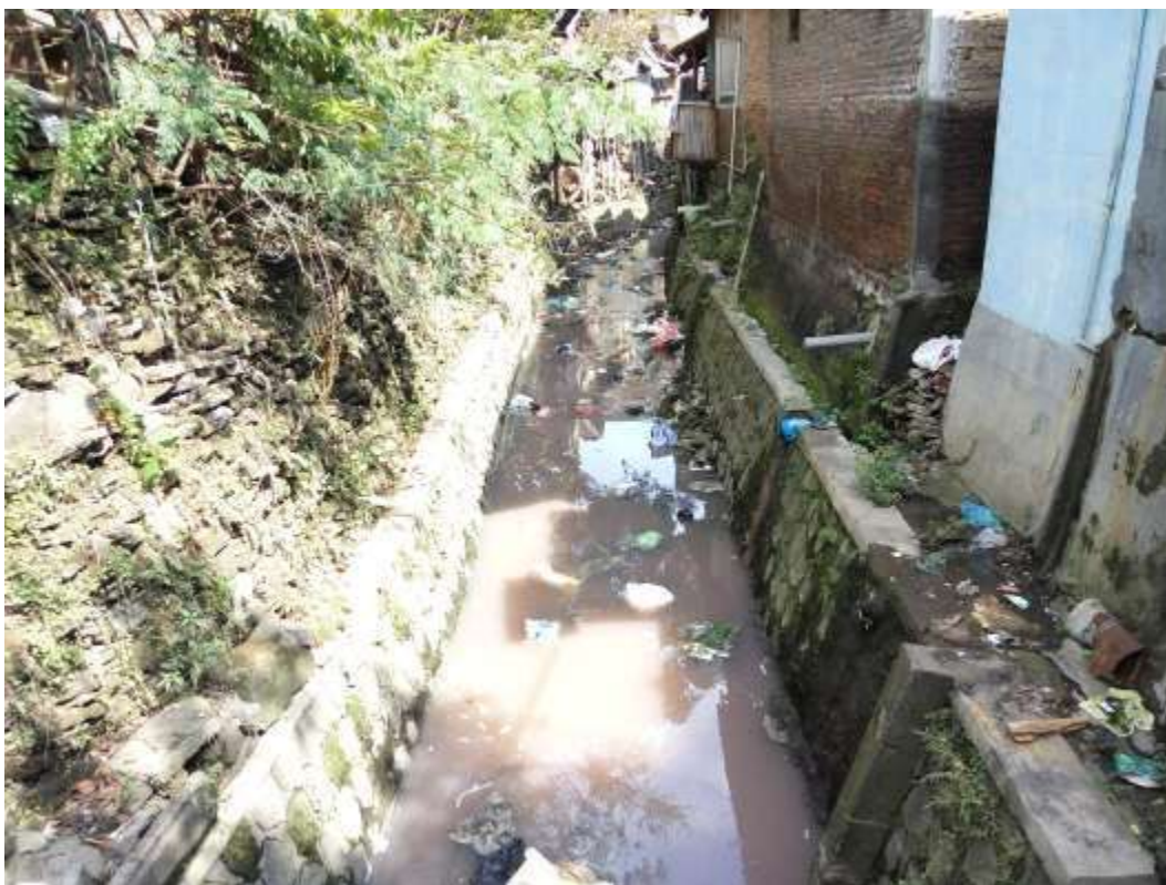
Gambar 4.12. Saluran Drainase Sub DAS 5
