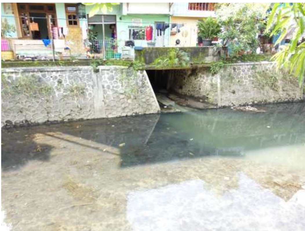
Gambar 4.10. Saluran Drainase Sub DAS 3
