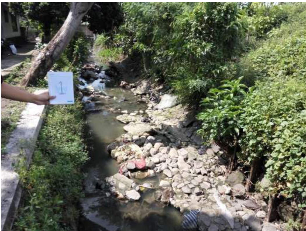
Gambar 4.8 Saluran Drainase Sub DAS 1
