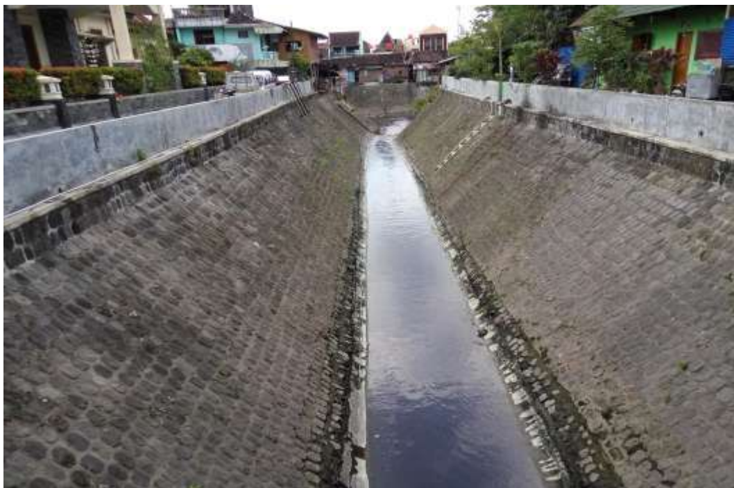
Gambar 4.13. Saluran Drainase Sub DAS 6
