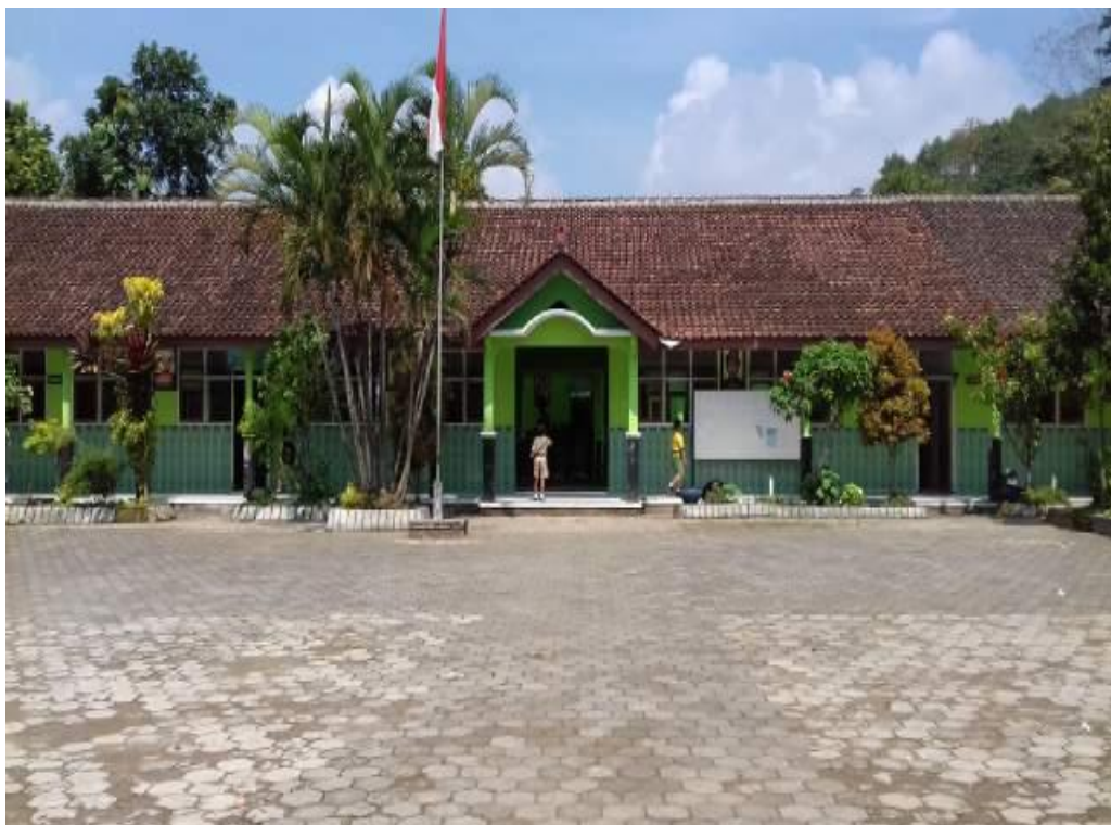
Gambar 19. Gedung Sekolah SDN 1 Muncar
