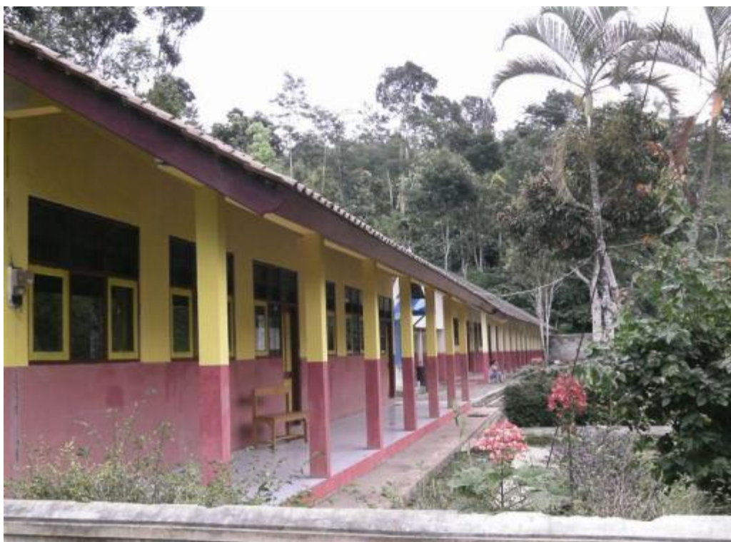
Gambar 20. Gedung Sekolah SDN 2 Muncar
