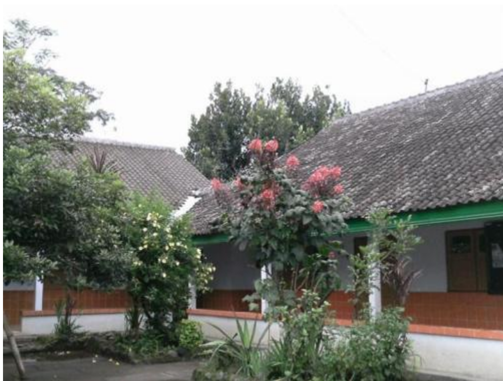
Gambar 21. Gedung Sekolah SDN 1 Banaran
