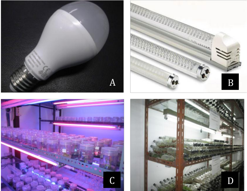
Gambar 8. Pencahayaan dalam ruang kultur. A. Lampu LED bentuk bolam, B. Lampu LED bentuk tabung, C. Ruang kultur dengan pencahayaan merah (Rahayu & Habibah, 2014), D. Ruang kultur dengan pencahayaan putih (Rahayu & Sumadi, 2015),
