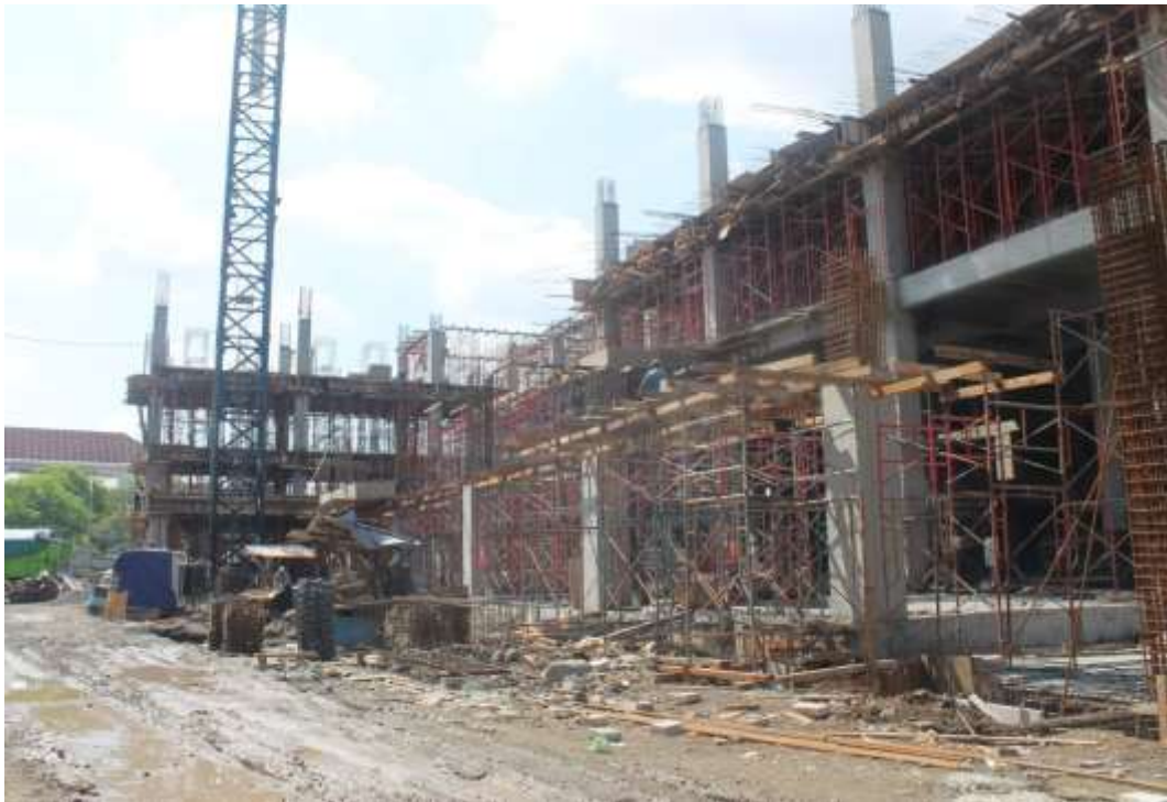
Gambar 2: Proyek pembangunan Tahap II
