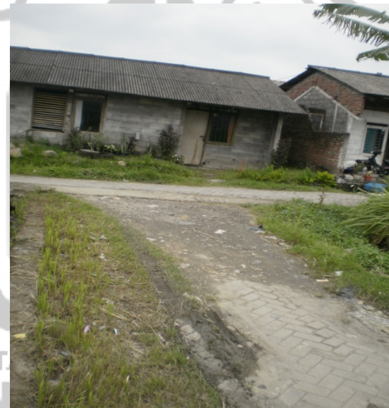
Jalan di Perumahan Warga RSS Perum Perumnas Pucang Gading
