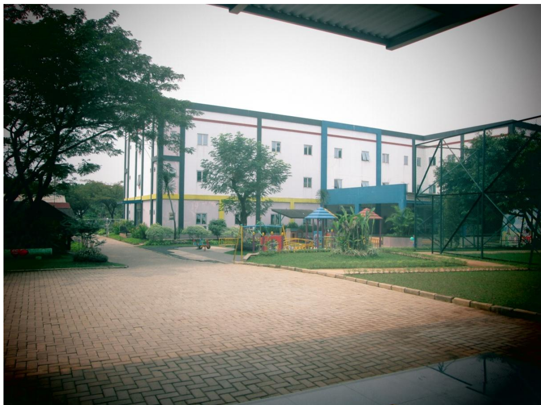
Gambar 6 Kondisi bangunan sekolah
