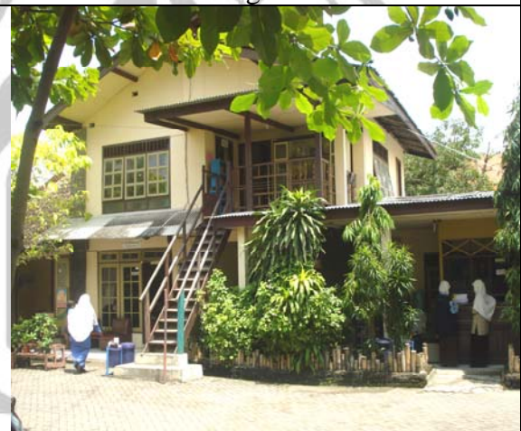
Bangunan kantor SD Islam Terpadu Bina Amal Semarang
