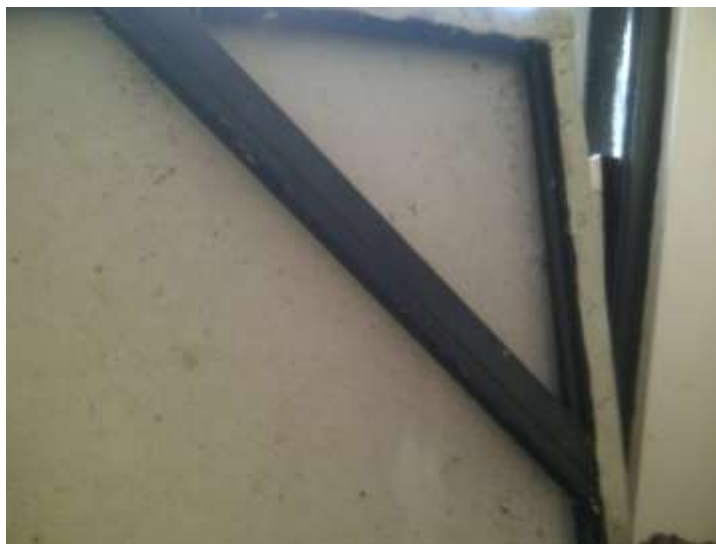
Gambar 3.2 Spanram Sumber : Dokumentasi Penulis
