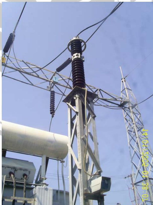
Gambar 3.1. Bentuk fisik arester tipe X AR 170 A 1 / 162
