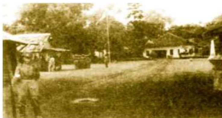
Suasana Rumah di Jalan Pegangsaan Timur pada Tahun 1945 (Sumber: 30 thn Indonesia Merdeka )
