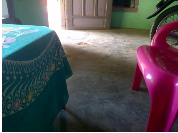
Kondisi lantai rumah responden
