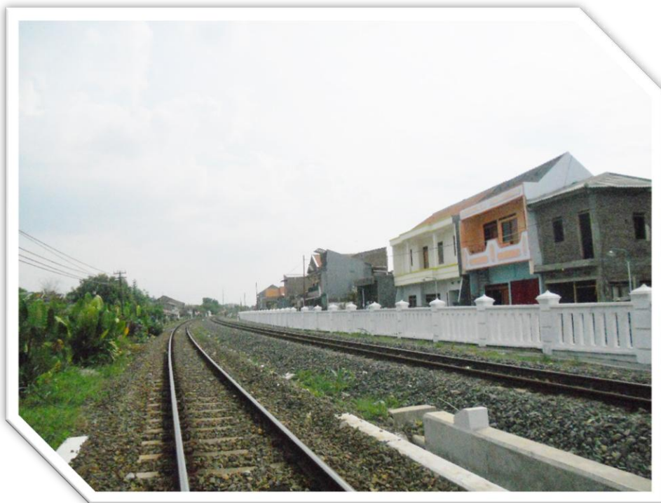
Proyek rel ganda yang baru selesai (kanan)
