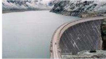
Gambar 2.10 Pembangkit Listrik Tenaga Air
