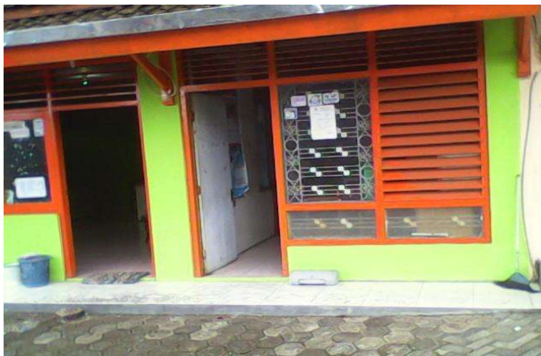
Tampak depan kantor PNPM-MP Kecamatan Getasan
