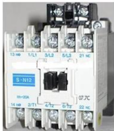
Gambar 3 Simbol kontak Kontaktormagnet seri Mithsubishi SN-12
