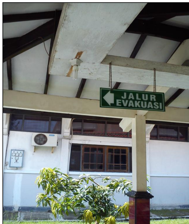
Pemasangan tanda jalur evakuasi
