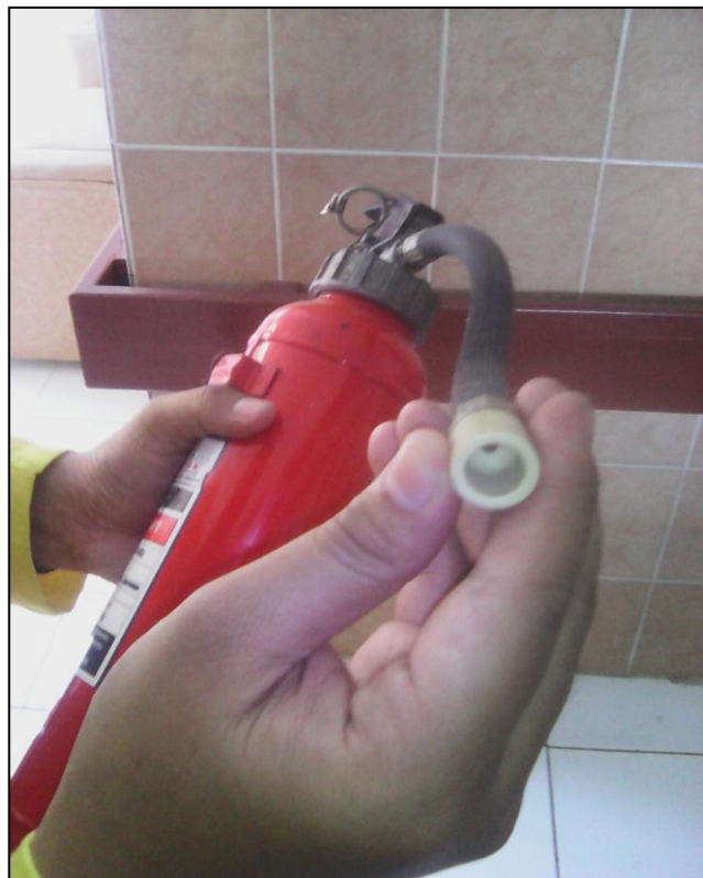
Mulut APAR yang tidak tersumbat
