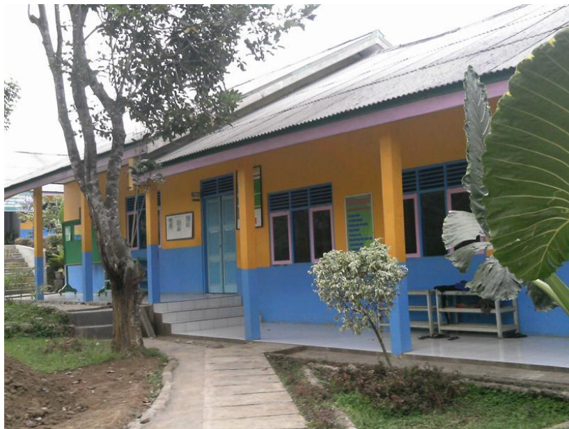
Kondisi bangunan sekolah
