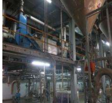
Kondisi di Area Dryer
