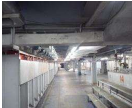
Kondisi Area Melting
