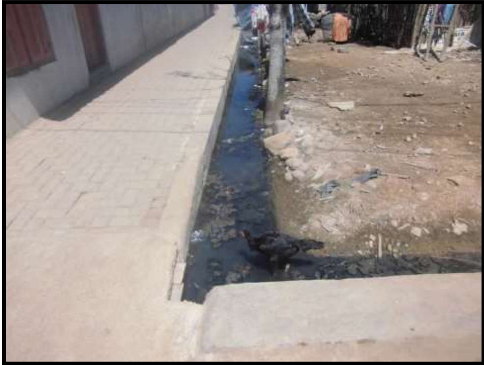
Kondisi SPAL terbuka di salah satu lokasi penelitian
