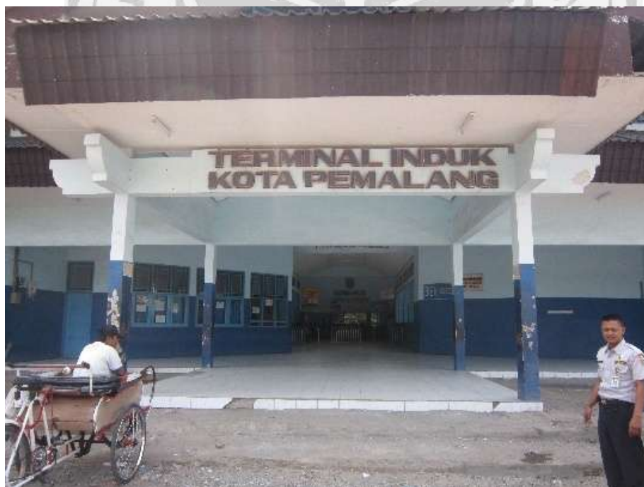
Gambar 2. Keadaan pintu masuk terminal
