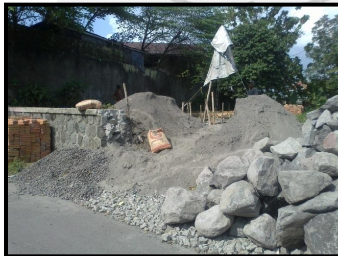
Gambar 19 Fondasi di Tanah Bekas Makam (Sumber: dokumentasi pribadi, diambil tanggal 1 Mei 2013)
