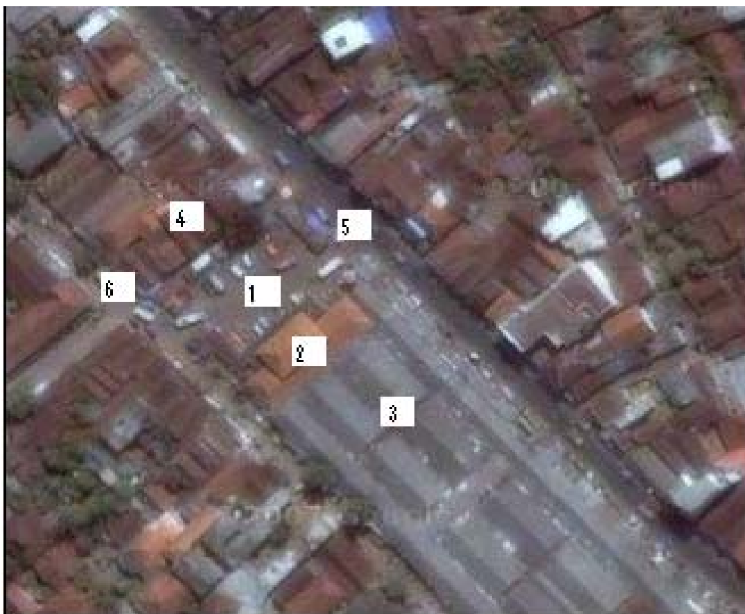
Gambar 4.2 Tampak Atas Terminal Bangsri
