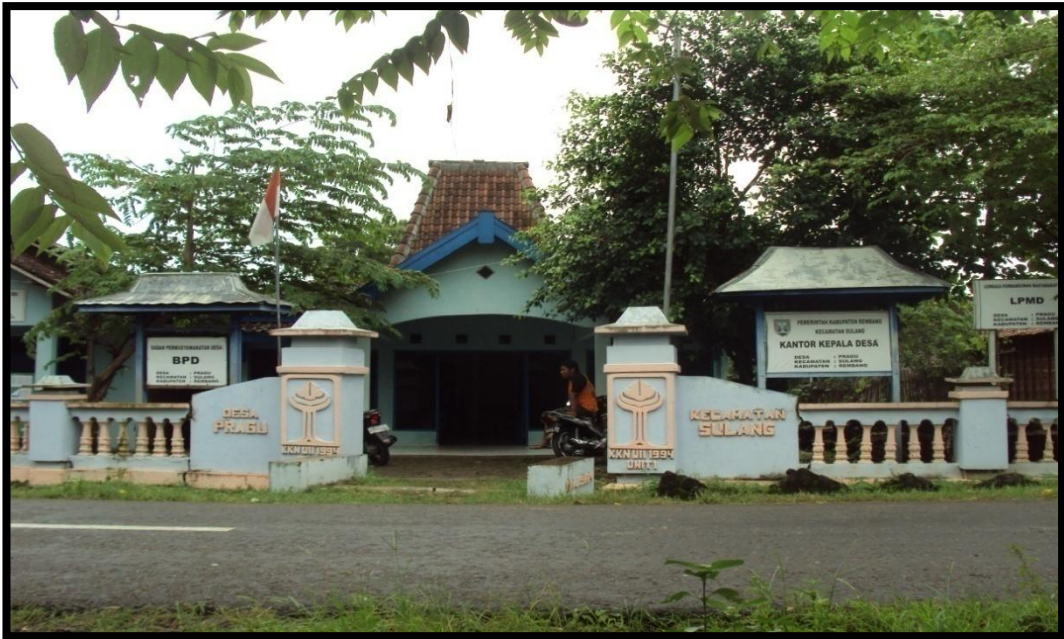
Foto : Balai Desa Pragu (Jama' Adi Saputra, 17 Februari 2013)
