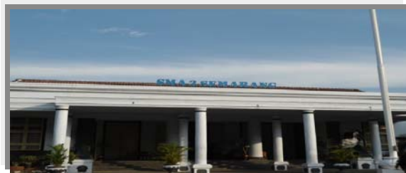
Gambar 1. Gedung Bagian Depan SMA N 3 Semarang (Sumber : Dokumentasi Pribadi)
