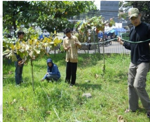
Memasang kabel di tiap elektroda
